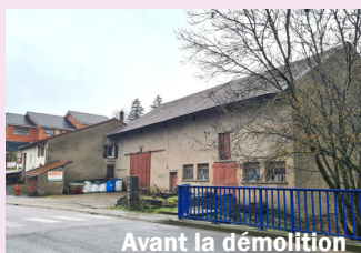
Avant la démolition
